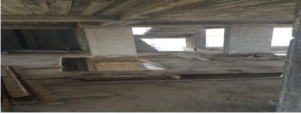
Şekil 4. Bina kat kenarlarının mevcut durumu ile ilgili resim
