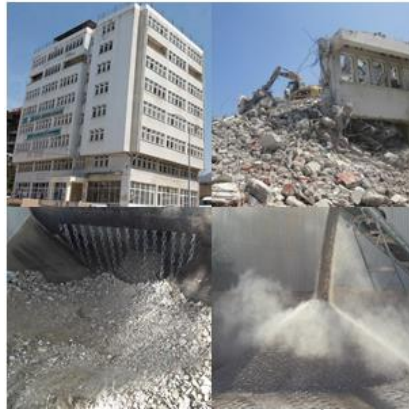
Şekil 1. İl özel idaresi binası, yıkılması ve konkasör işlemi
