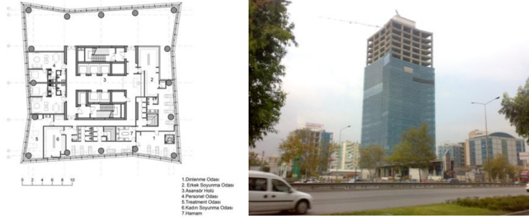
Şekil 1. Bayraklı Towera. Kat Planı (URL1) b. Yapım Aşaması (URL 2)
