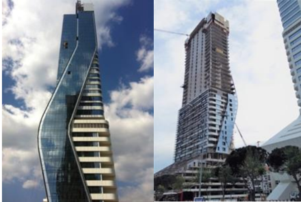
Şekil 5. Folkart Towers Kompozit Cephe ve Yapım Aşaması (URL 7)
