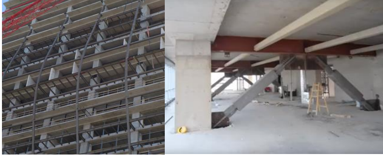
Şekil 4. FolkartTowersa. Cephe Strüktürleri (URL 6) b.Outrigger Sistem (URL 6)
