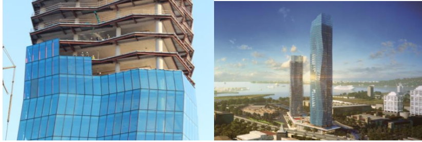
Şekil 3. MistralTowera. Ofis Bloğu Cephe Sistem Montajı (URL5)b. Ofis ve Konut Blokları (URL 4)
