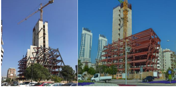
Şekil 9. Biva Tower a. Diagrid sistem (URL12)b. Çelik sistem (URL-12)
