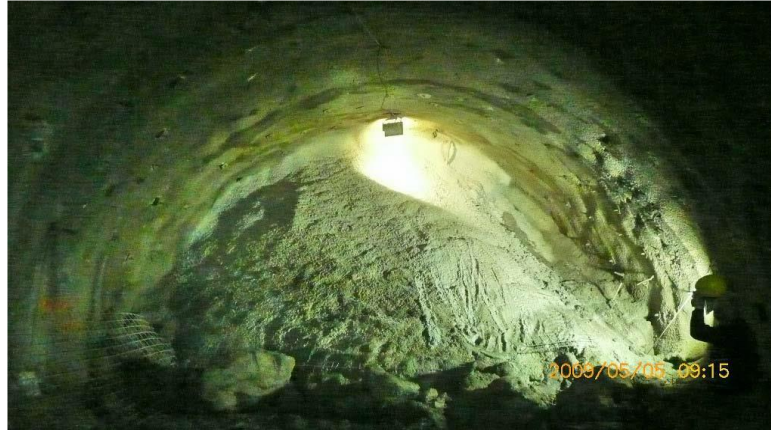
Şekil 7. Km: 4+709 'da tünelde göçük aynasının püskürtme betonla emniyete alınmış durumu
