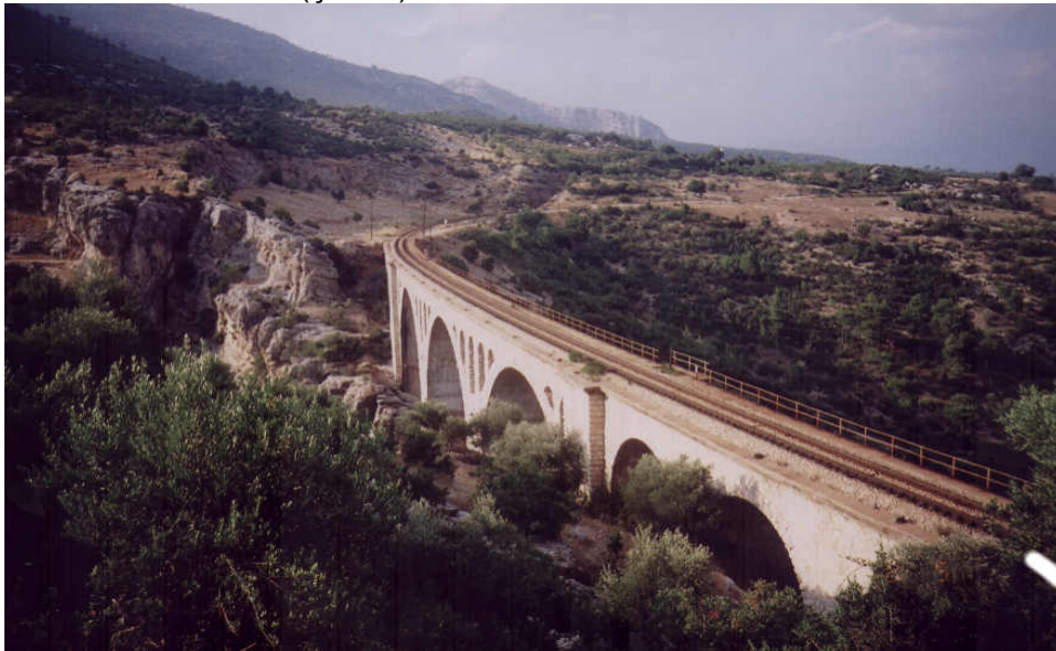
Şekil 6. Üzerinden Tren Yolu Geçen Köprüden Bir Görünüm
