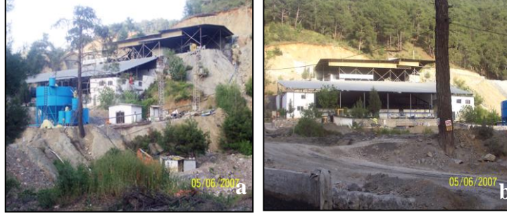
Şekil 2. Minsan Madencilik A.Ş. krom zenginleştirme tesisleri (a-b)
